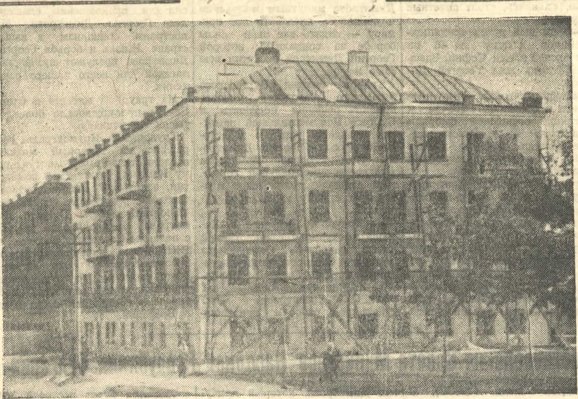
Новыми зданиями украшается улица Радищева. На снимке: жилой дом № 52, строительство которого заканчивает стахановский участок Ремстройтреста. Фото М. Харьковского.
