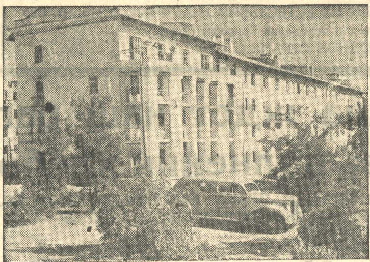
Сталинград. Восстановленный 40-квартирный дом в Верхнем поселке Сталинградского тракторного завода.
