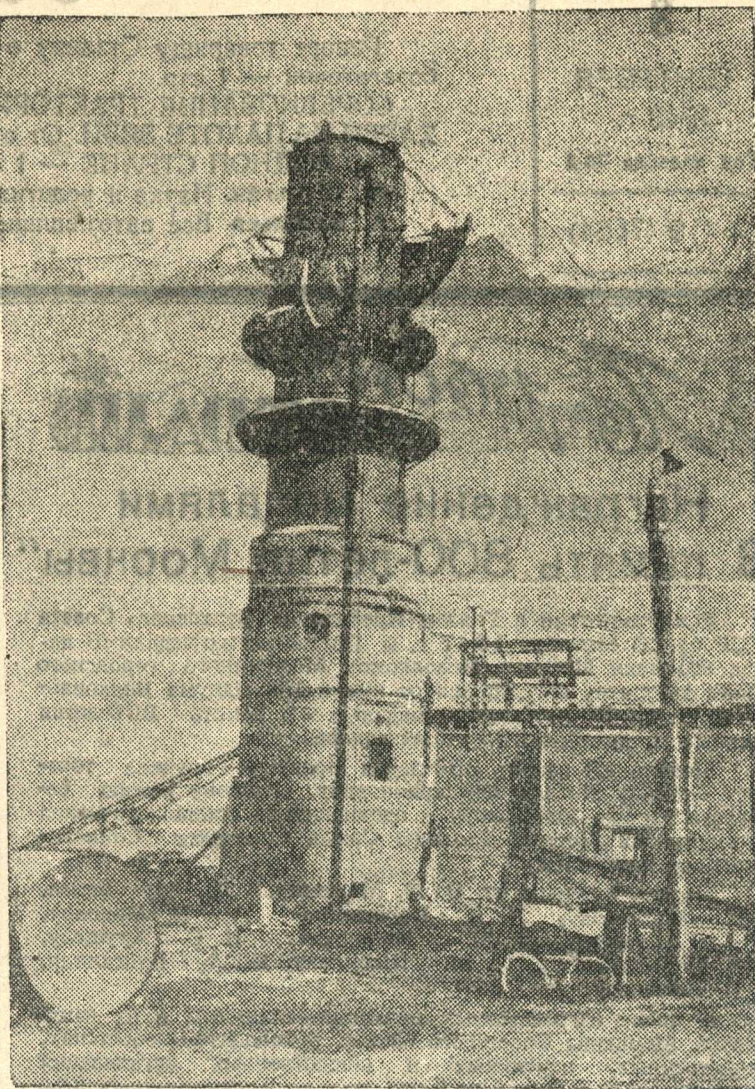
На строительстве Краснояружского сахарного завода.
