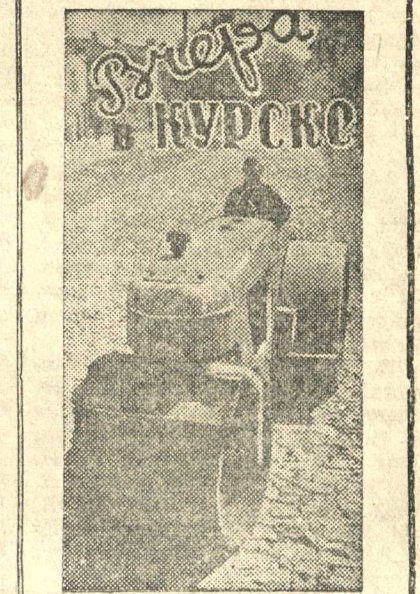
Началась укладка новой мостовой на Мирной улице.
