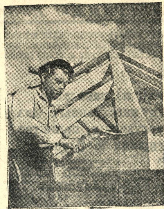
Демобилизованный офицер Г. А. Писанник, получив государственную ссуду, строит себе в Курске дом. На снимке: плотник И. Кобелев на строительстве дома. Фото А. Говорова.
