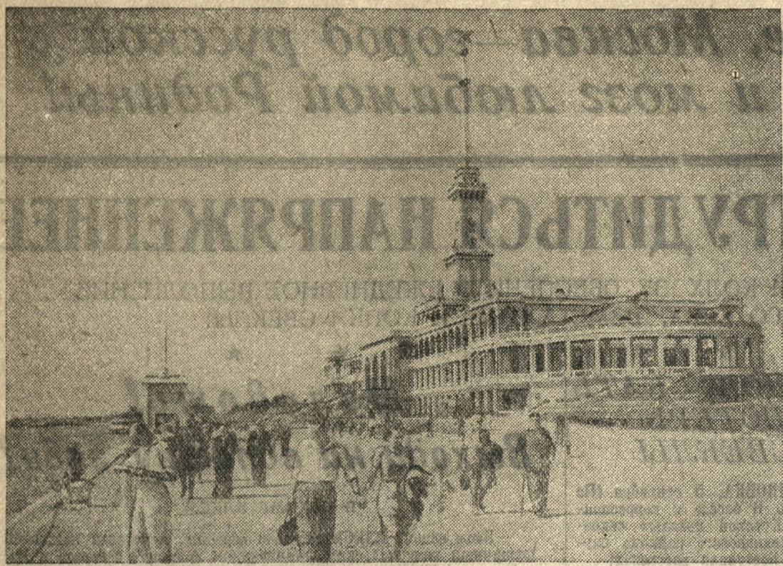
Химкинский вокзал на канале «Москва-Волга».
