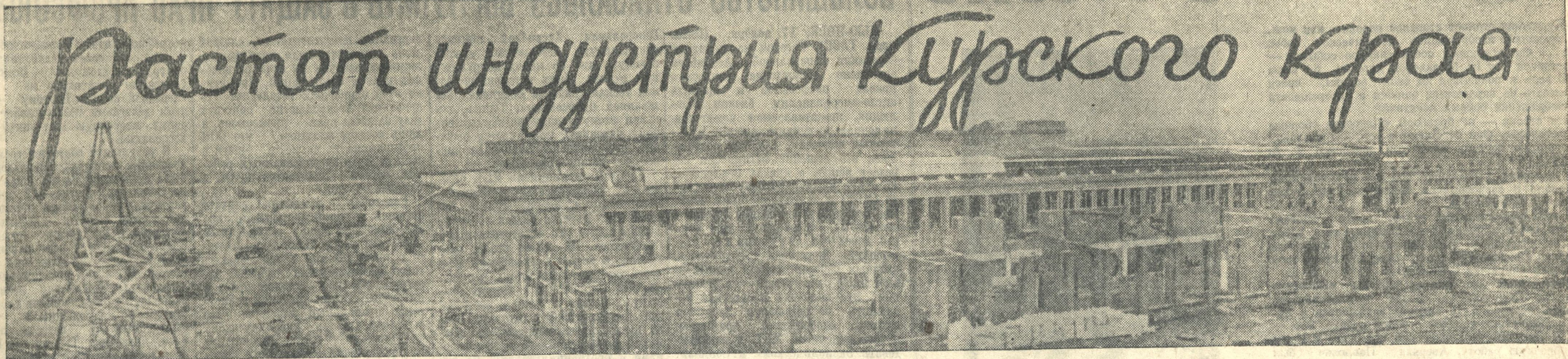
Под Курском вырастают корпуса новых заводов. На снимке: общий вид строительной площадки резинового завода.
