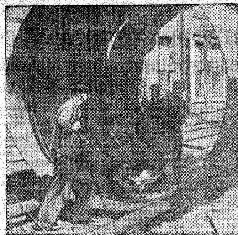
На Львовском литейно-механическом заводе Министерства путей сообщения. На снимке: бригадир В. Каплин с подручными В. Цыганковым и электросварщиком В. Алешинским за сборкой цистерны емкостью в 60 куб. метров.
