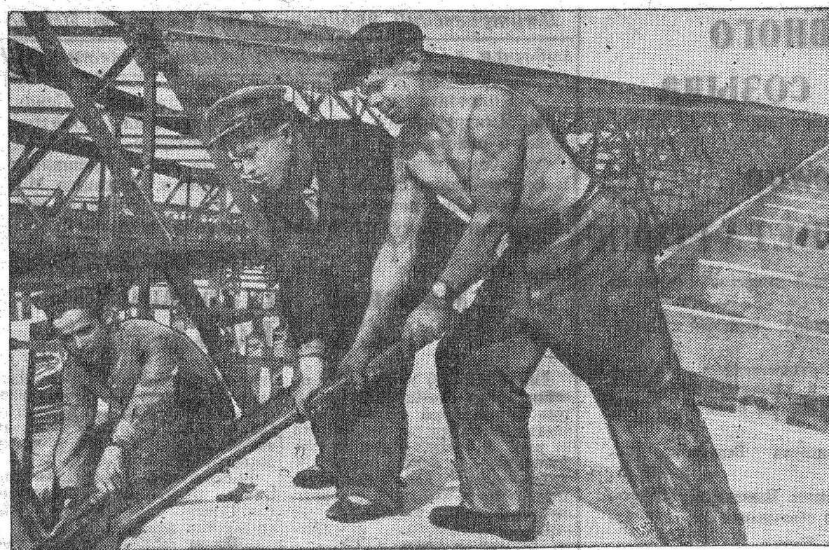
На стройке Курского резинового завода. На снимке: бригада П. Чаплыгина за укреплением металлоконструкций пролетов прессового цеха (слева направо): П. Чаплыгин — бригадир, И. Зинченко — мастер и Ф. Прасолов — слесарь-монтажник.
