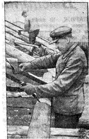
Началось строительство 4-квартирного дома для железнодорожников 17 дистанции службы пути. На снимке: бригадир лучшей бригады плотников Я. Д. Бойнов за работой.
