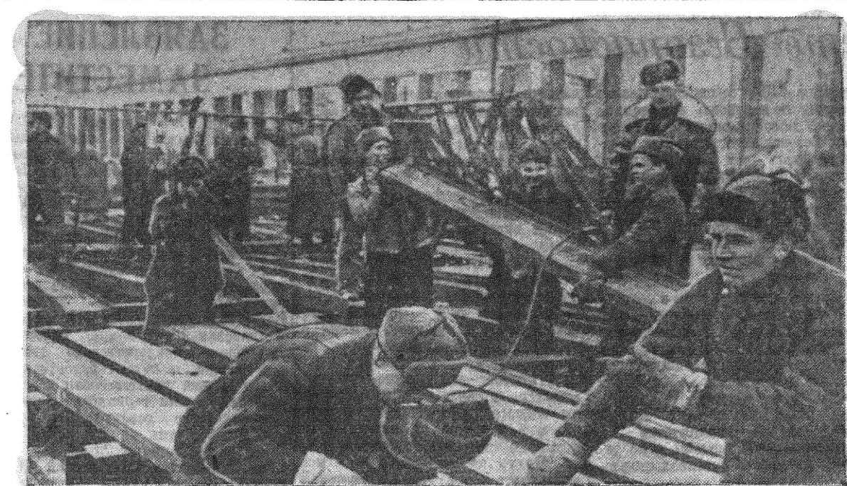
Бригада сборщиков металлоконструкций С. Лашина на строительстве завода резнопластических изделий служит примером, перевыполняя свои задания вдвое и больше. На снимке: С. Лашин (справа) со своей бригадой. Фото О. Сизова.
