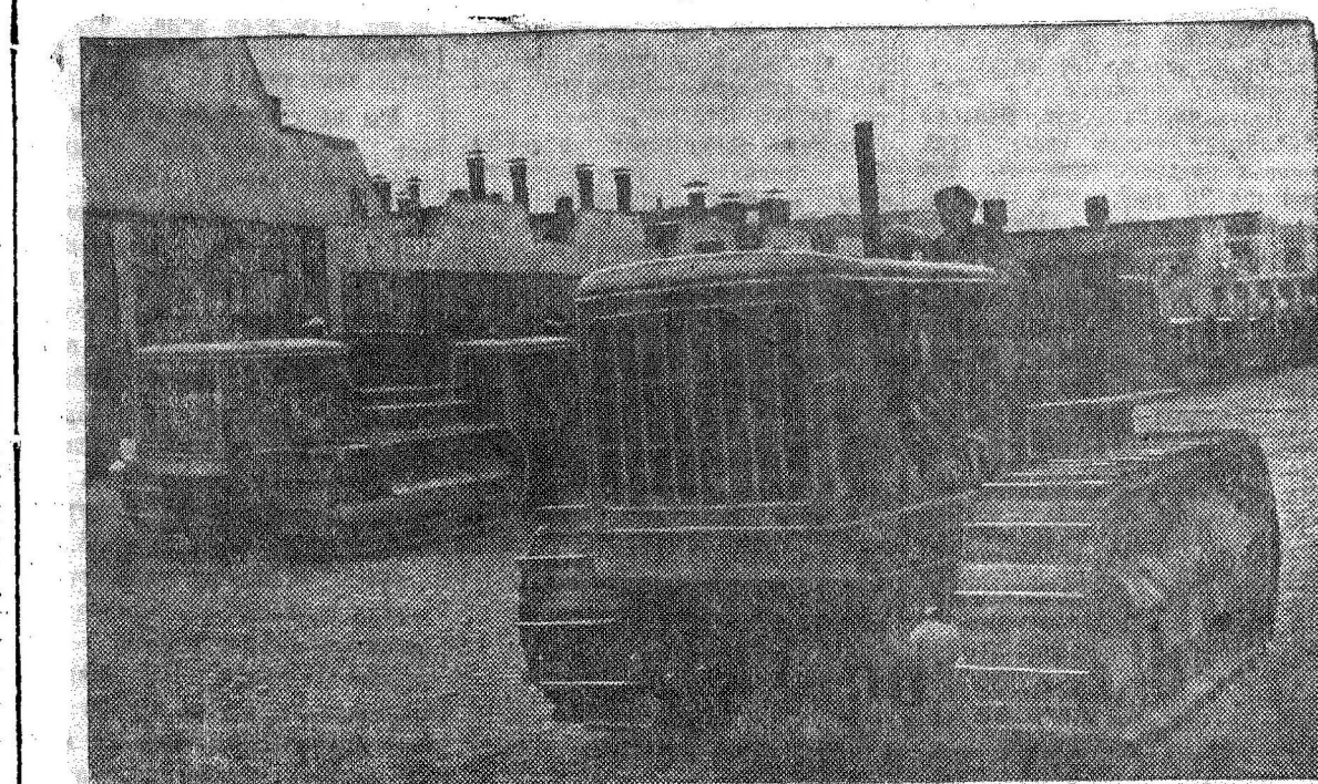
Пятилетний план в действии. Курский завод на Урале выпускает первую партию тракторов новой марки «С-80». Это — усовершенствованный гусеничный трактор мощностью в 30 лошадиных сил с дизель-мотором. Девять скоростей, вместо четырех, которыми снабжен трактор старой марки «С-65», делают новую машину высокоманевренной. На снимке: испытания тракторов «С-80», на заводском дворе. Фото В. Георгиева.
