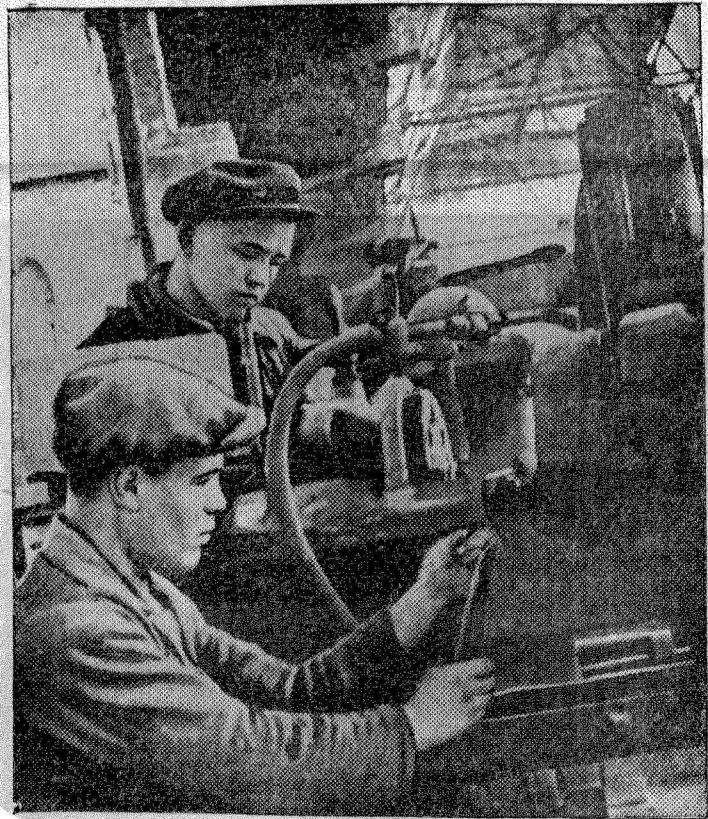
На аккумуляторном заводе идет установка оборудования. На снимке: стахановцы завода Я. Кузнецов и Н. Челноков за монтажом станка. Фото А. Богданчикова.
