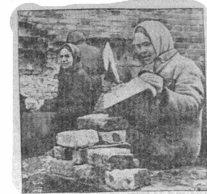
Добровольческо-строительная бригада Н. Б. Лаврентьева (Сталинский район г. Курска) работает на стройках с 1943 года. На снимке: бригада за подготовкой кирпича к кладке. Справа налево: бригадир Н. Б. Лаврентьев, домохозяйка А. М. Анпилогова и Л. С. Орницкая.
