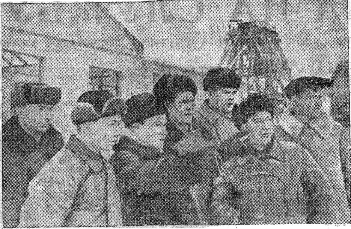
Развернулись работы по восстановлению Губкинского рудника КМА. На стройку вернулись старые, кадровые работники — пионеры разработки Курской руды. На снимке начальник КМА-строй тов. Кислов (третий слева) и старые работники КМА-строй т. т. Сарафанов — начальник шахты, Г. А. Захаров — нач. отдела оборудования, П. М. Кострикин — механик шахты, Н. Д. Масловский — нач. цеха, С. С. Погорельский — мастер, А. Б. Малыгин — мастер.
