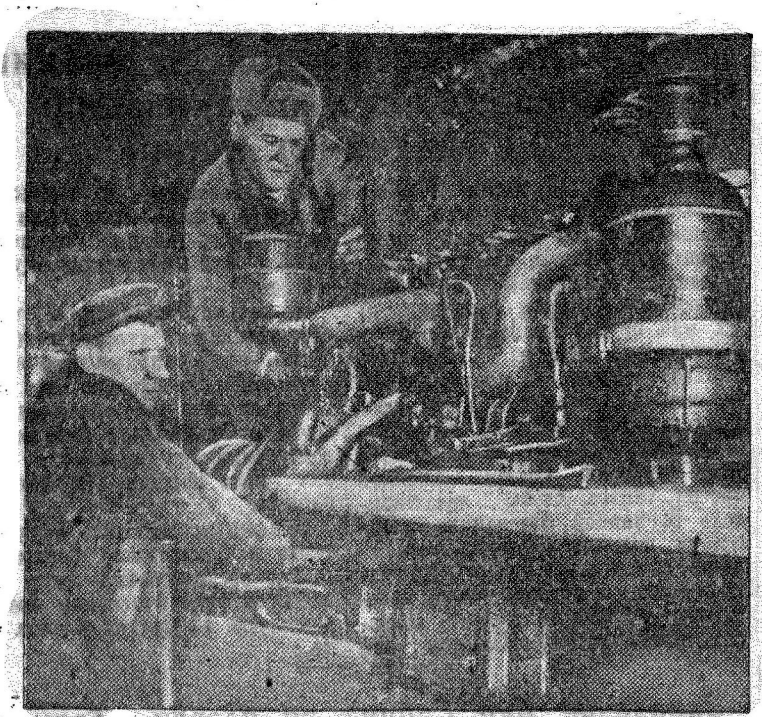
На Кировском заводе (Урал) приступили к сборке первого трактора новой марки «О-80». Это мощный усовершенствованный гусеничный трактор с дизельным двигателем.
