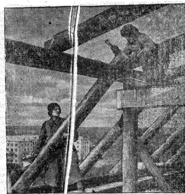
Успешно идет восстановление Курского ликеро-водочного завода. На снимке: плотники стахановцы Конев (справа) и Буткевич устанавливают стропила, на крыше главного корпуса. Фото А. Говорова.
