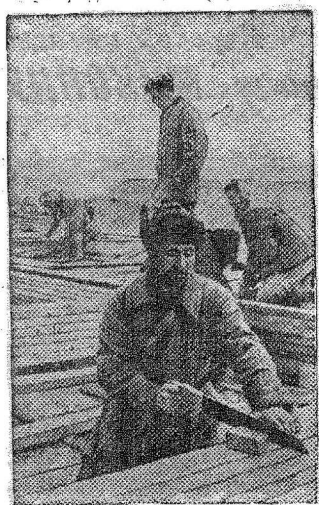
На 200 процентов выполняет норму на строительстве элеватора на ст. Прохоровка плотник А. Н. Шапов. На снимке: тов. Шапов, на втором плане инженер Г. Н. Бирюков.
