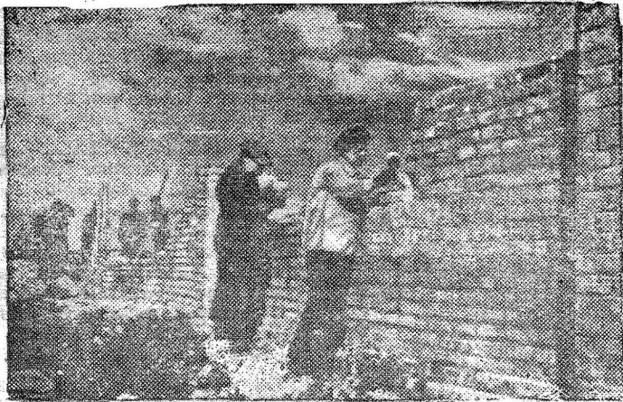
В колхозе «Веселое житие» (Шебекинский район) начата постройка свинарника на 250 голов. На снимке: кладка стен. На первом плане—колхозный каменщик Т. М. Славгородский. Фото В. Турбина.
