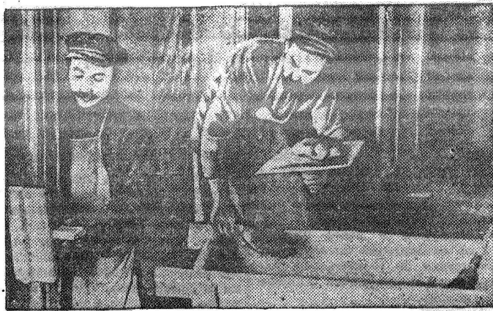
На стройке правого крыла Дома советов. Лучшие штукатуры строительства И. А. Ткаченко и Д. Т. Киселев за отделкой дверей. Фото А. Богданчикова.
