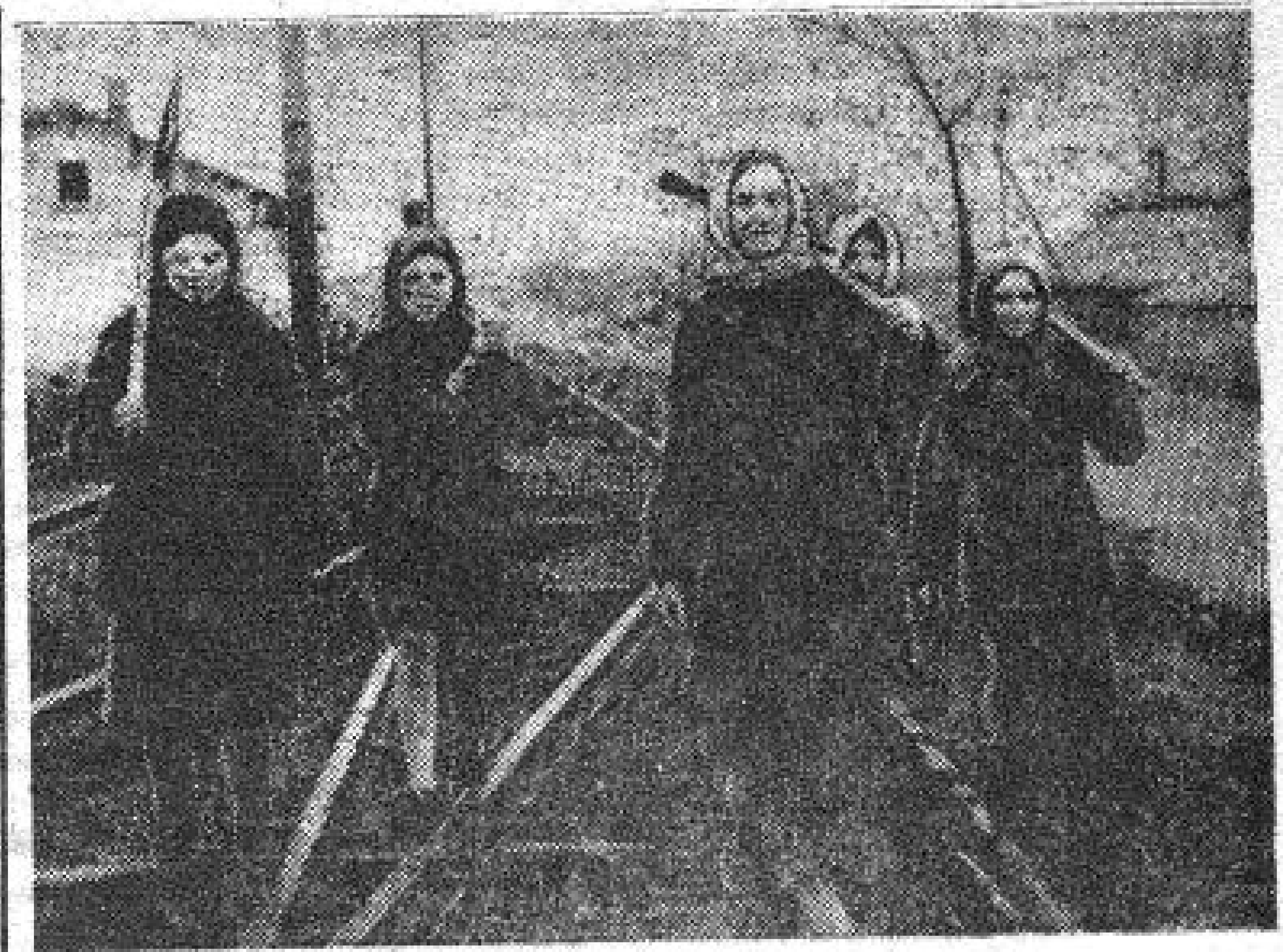
Бригада жителей Первомайской улицы, Кировского района, закончила земляные работы по подготовке трамвайного пути. На снимке (слева направо): Полова Ная, Некорощева Н. И., бригадир Якуба П. А., Некорощева З. П. и Сливкова Н. И. — во время работы.
