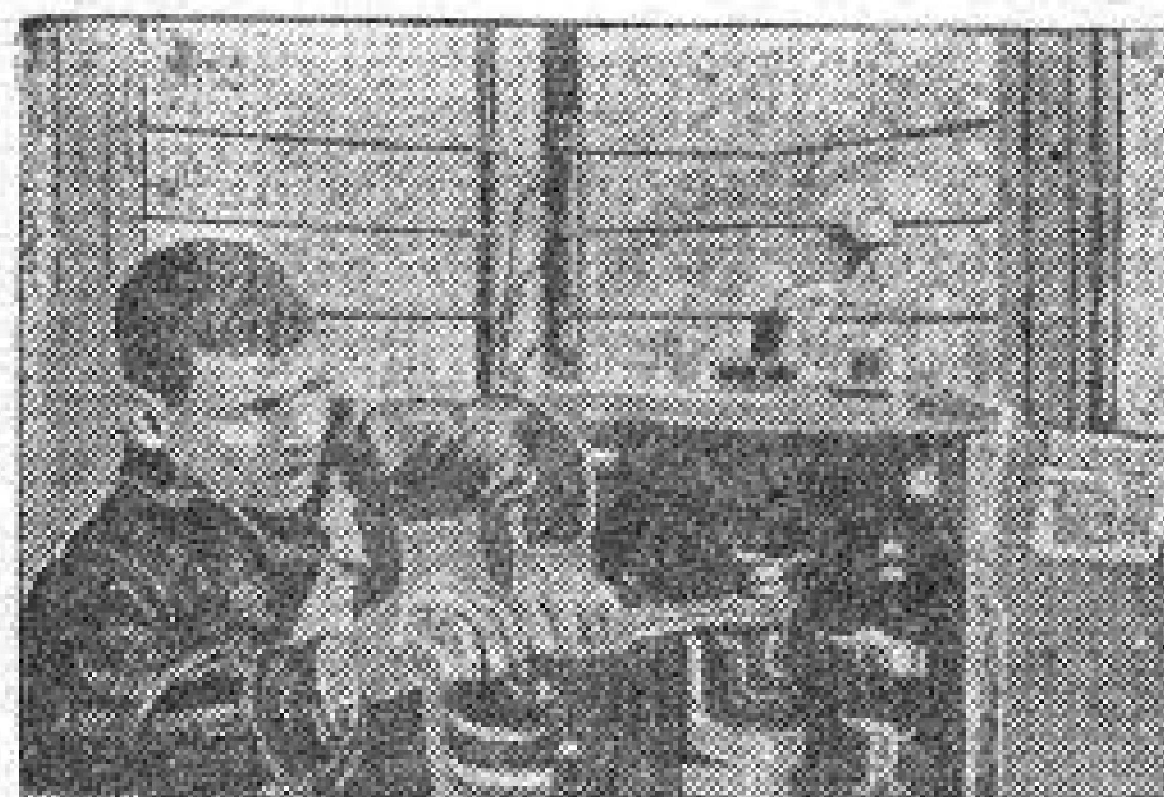
Коллектив трампарка начал восстанавливать трамвайные вагоны. На снимке: ученик-слесарь Виктор Мишук за ремонтом мотора. Фото А. Михатова.
