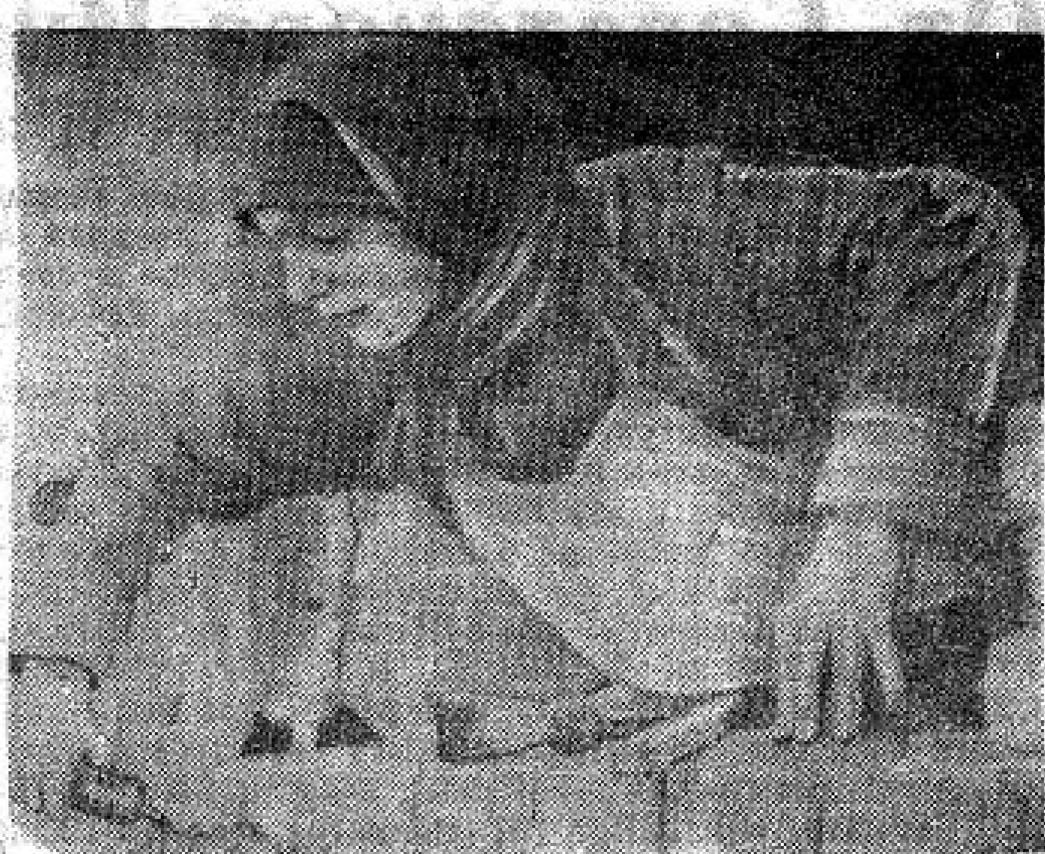
НА ОДНОМ ИЗ УЧАСТКОВ СПЕЦИАЛЬНОГО СТРОИТЕЛЬСТВА. На снимке: А. К. Демущина за кладкой кирпича. Фото А. Михатова
