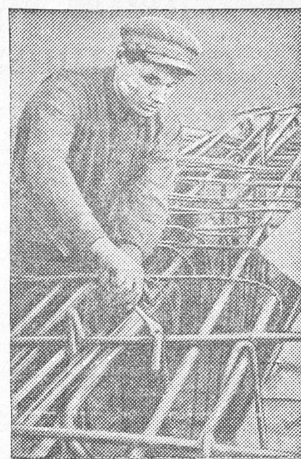
Заканчиваются работы по сооружению бетонного фундамента под новую турбину на курской электростанции.
