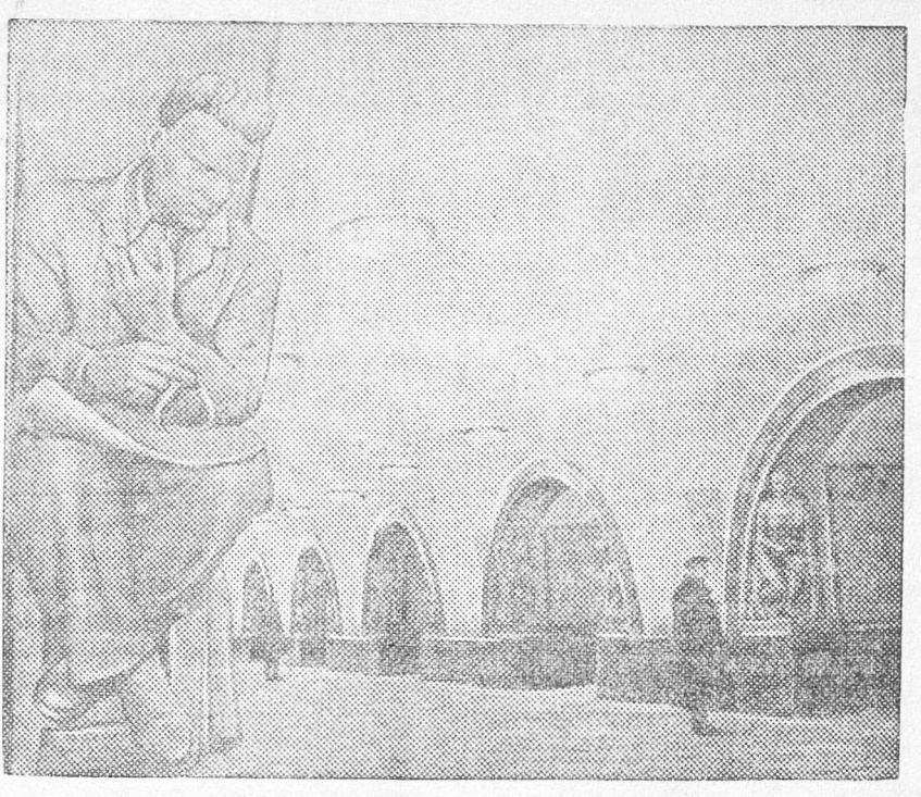
Поправский радиус Московского метрополитана вступил в предпосредственный период. Заключаются договоры, проверка автоблокировки, оформление станций и перронов. На снимке: станция метрополитана «Площадь революции». Скульптурное оформление выполнено заслуженным деятелем искусств проф. М. Г. Манисером.
