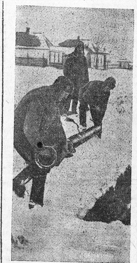
Весной этого года жители окраинных улиц города Курска получат новые водоразборные колонны. На снимке: прокладка водопроводных труб на улице Подвойского. Фото Богданчикова.
