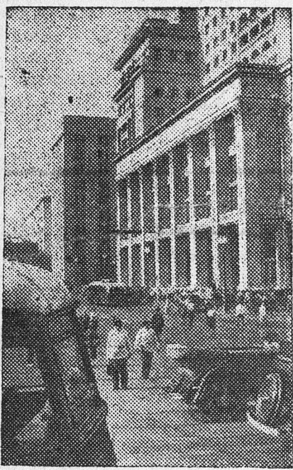
НОВАЯ МОСКВА. На снимке: вид гостиницы «Москва» с улицы Горького. (Союзфото).
