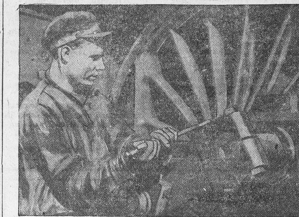
Лучший слесарь пассажирского парка курского депо Николай Шолупов систематически выполняет свой план на 350—400 процентов и работает без брака. На с ним же: тов. Шолупов за ремонтом дышла паровоза. Фото ШЕХОВЦОВА.
