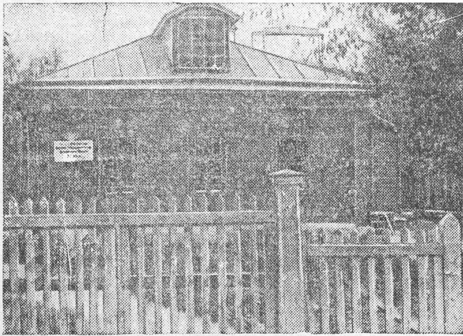
На снимке: дом по проспекту им. Л. М. Кагановича в Подольске (Московской области), в котором в 1900 году жил В. И. Ленин. На доме установлена мемориальная доска. (Союзфото).
