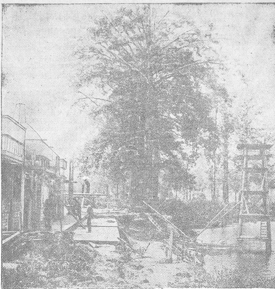
Строительство новой водной станции на р. Тускарь (б. Бова дача). Фото А. БОГДАНЧИКОВА.
