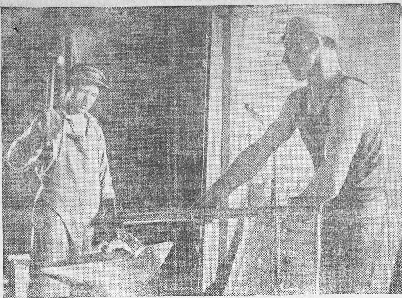
Кузнец Самохин и молотобоец Ермаков—стахановцы 7-й дистанции пути (Курск), установившие всеобщий рекорд по изготовлению противоугонов, в стахановскую декаду показывающие замечательные образцы работы. За смену изготовлено 100 противоугонов, вместо 20 по норме. На снимке: кузнец Самохин и молотобоец Ермаков за работой.
