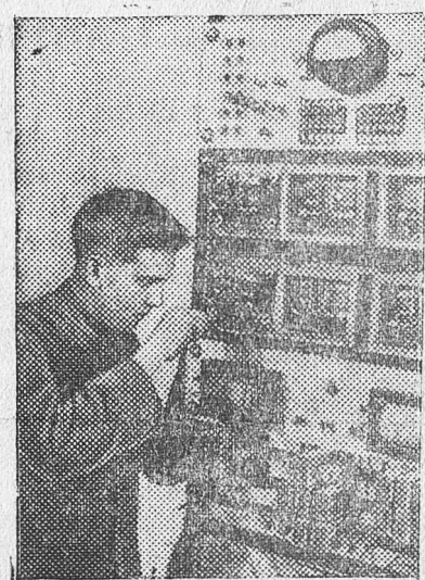
НА СТРОИТЕЛЬСТВЕ КУРСКОЙ ТЕЛЕФОННОЙ СТАНЦИИ
