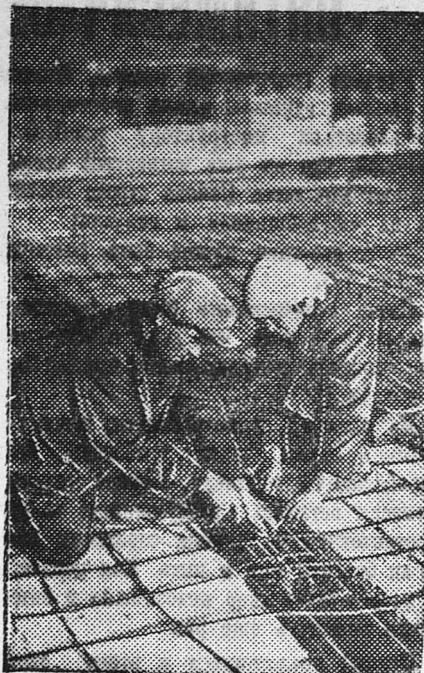
Аматурные работы для железобетонного перекрытия дежмеры вновь строящейся бани в Курке. На снимке: Аматурщики Чурилов Т. и Чурилова М. за работой. Фото БОГДАНЧИКОВА.
