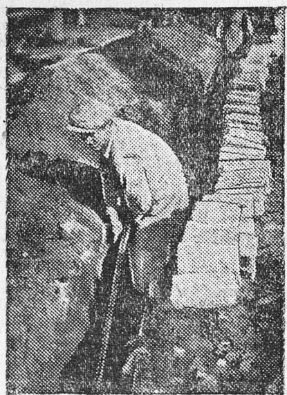
Прокладка высоковольтного кабеля от трансформаторной будки табачной фабрики до лесозавода.
