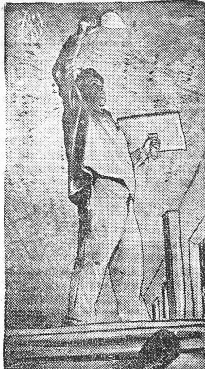
Заканчивается строительство нового здания воронечной неполной средней школы (Гроснянский район). На снимке: штукатур Кулешов В. С. производит штукатурку потолка. Фото ГОВОРОВА.
