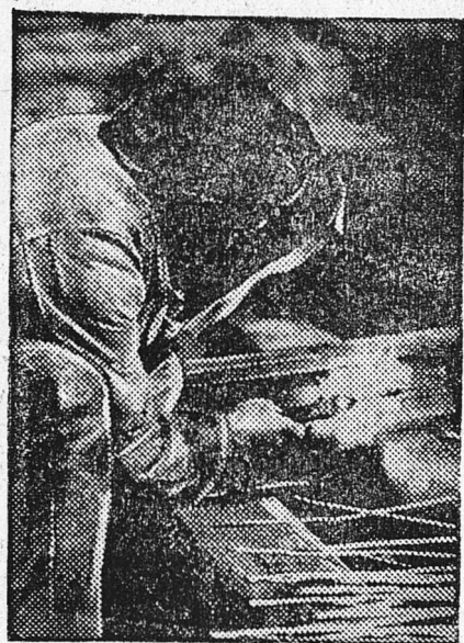
Электросварка рельсов на строительстве трамвайной линии по ул. Добролюбова (Нурск). Фото ГОВОРОВА.
