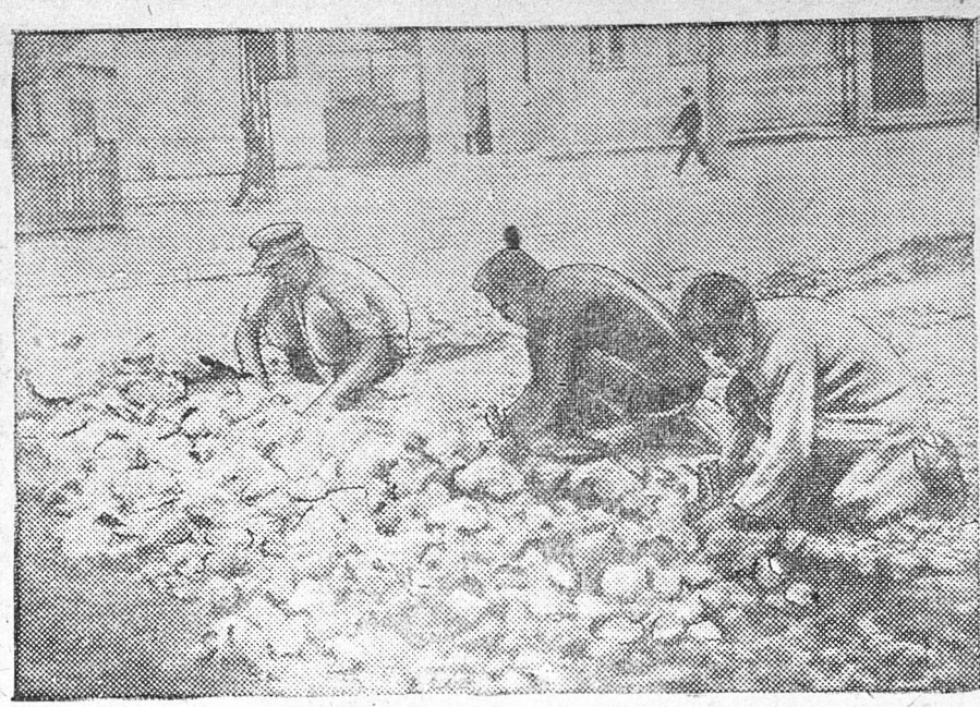
Ремонт мостовой на Московской улице в Орле. Фото НИКОЛАЕВА.
