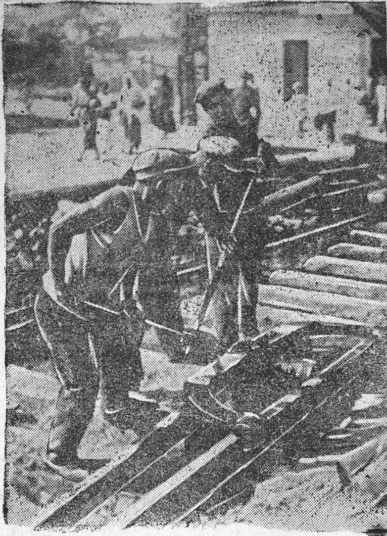
Ремонт трамвайной линии на ул. Дзержинского в Курске.
