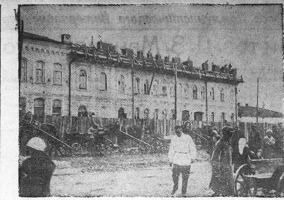
Начата надстройка 3-го этажа дома, где будет помещаться облЗУ.
