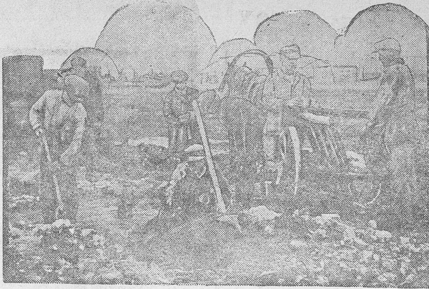
Подвозка камня к элеватору (ст. Тербунь).
