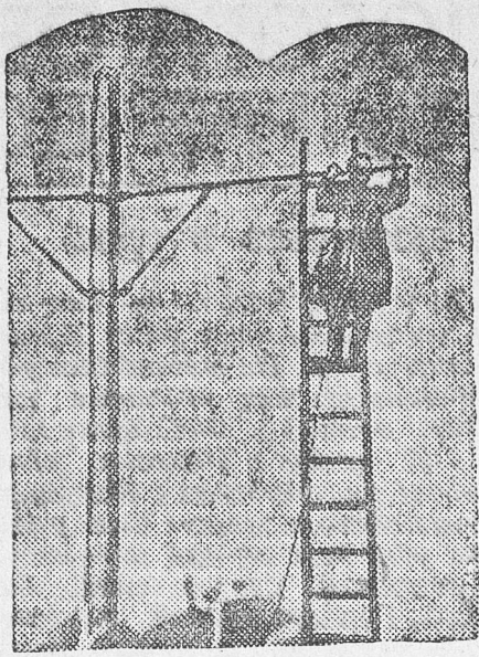
Трамвай скоро пойдет по новому мосту
