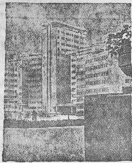
К 17-й годовщине Октября заканчивается строительство шантского дома проектов в Харькове.
