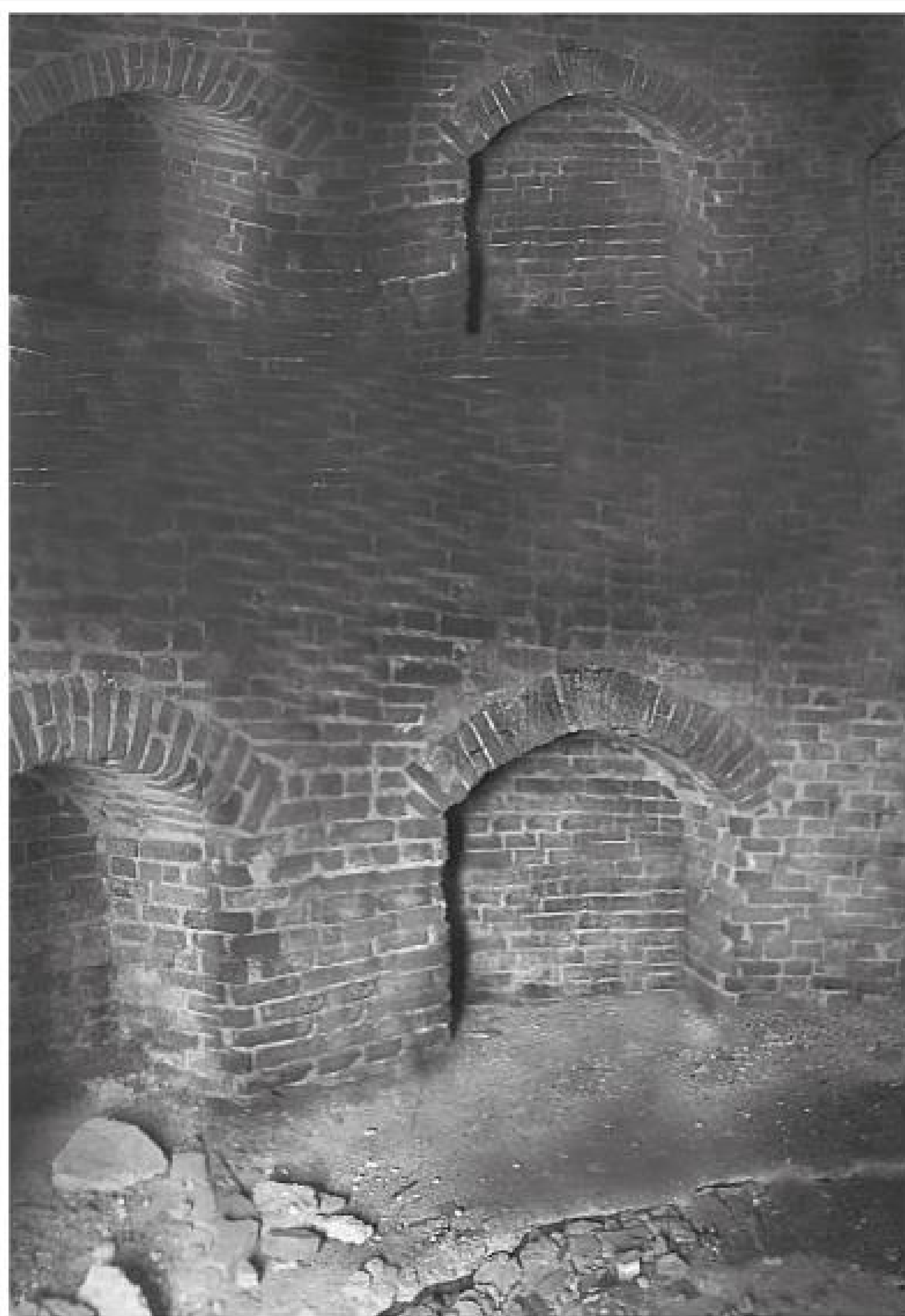
Башня изнутри. Просторные ниши на двух уровнях, — по 8 в каждом. Так бы она выглядела, если бы не была разделена по вертикали деревянным полом-потолком. Провалившийся в центре цементный пол-стяжка нижнего уровня.
