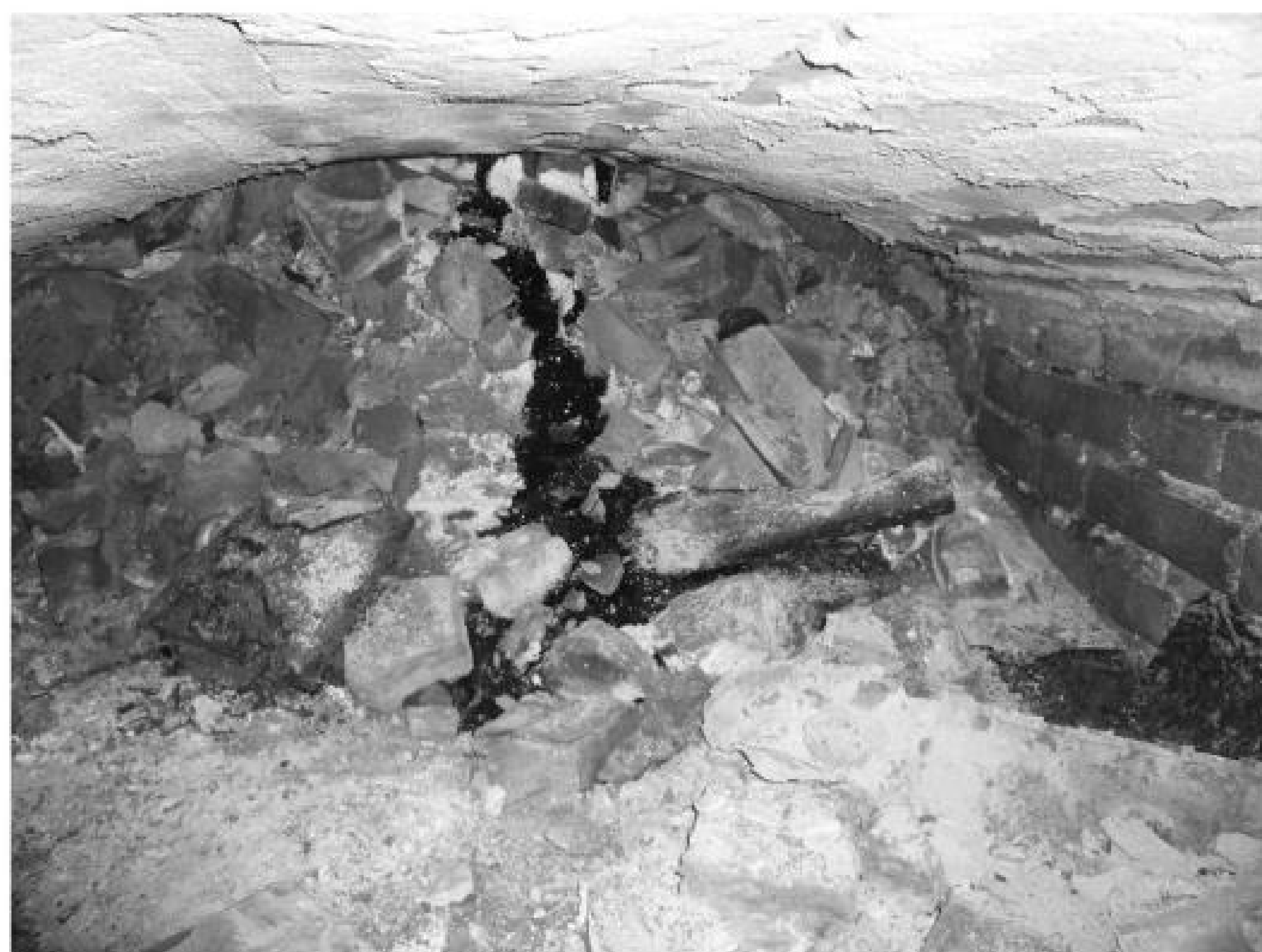
Завал, которым заканчивается фрагмент подземного хода под Воскресенским храмом.
