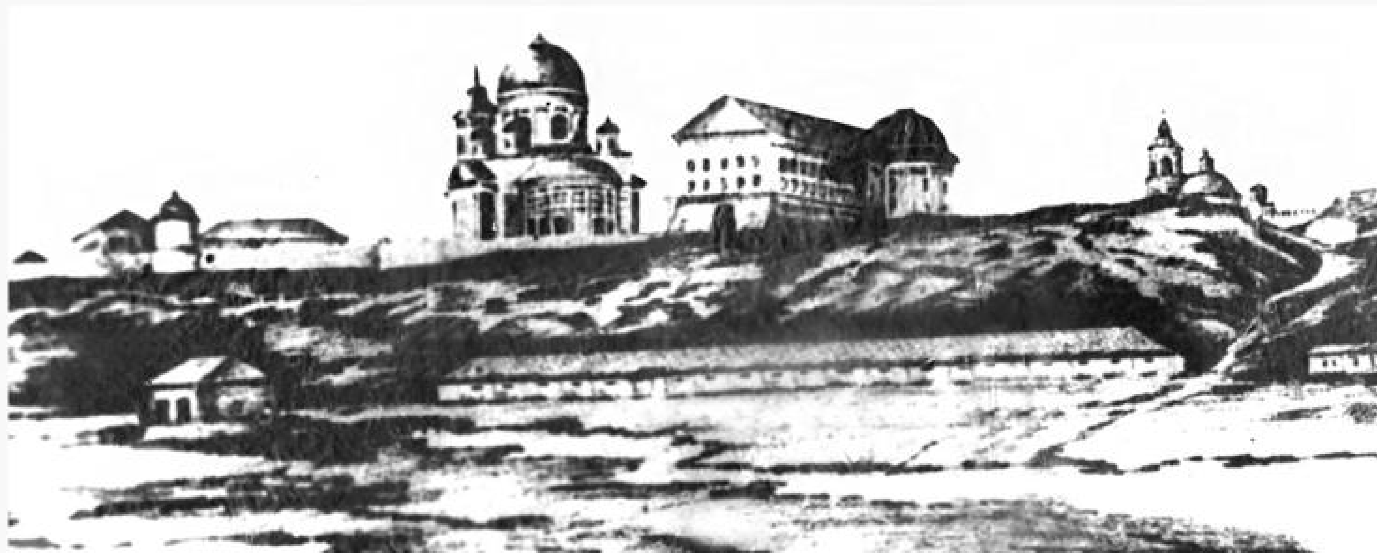
Знаменский собор еще достраивается - апсида еще в лесах. Правее - здание присутственных мест. Рисунок военных топографов.
