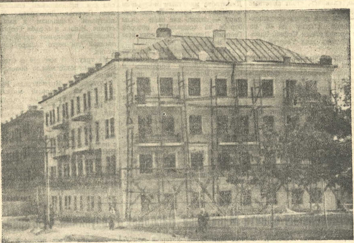
Новыми зданиями украшается улица Радищева. На снимке: жилой дом № 52, строительство которого заканчивает стахановский участок Ремстройтреста. Фото М. Харьковского.
