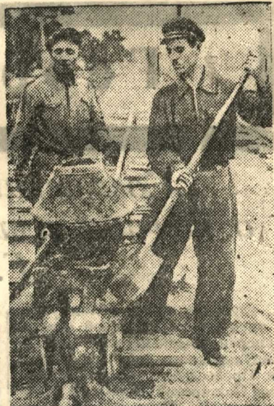
В Курске идет строительство трамвайной линии до станции Рышков. На снимке: сварщик трамвайной тресты И. Колесников (справа) и А. Шаровский производят термитную сварку стыков рельс. Фото А. Говорова.
