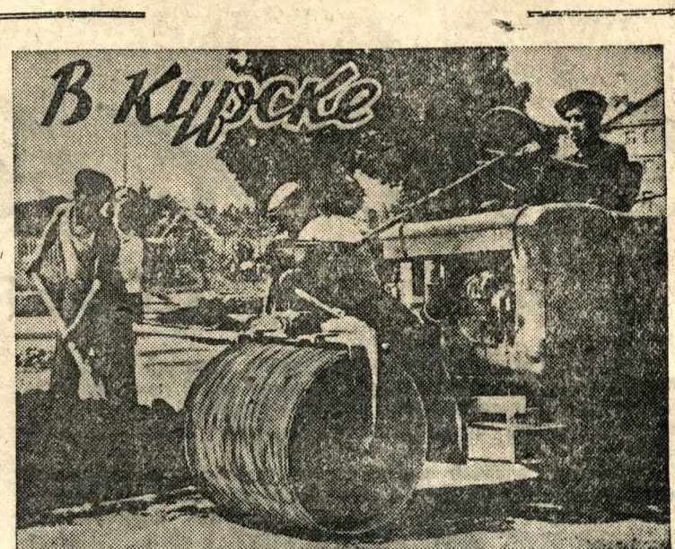
Курск благоустраивается. Асфальтирование улицы.
