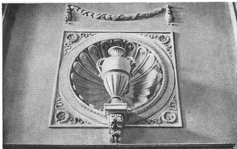
46. Деталь отделки главного зала Клуба железнодорожников
